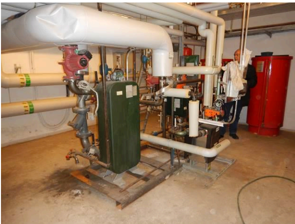
Kiinteistön kaukolämmön alajakokeskus.
