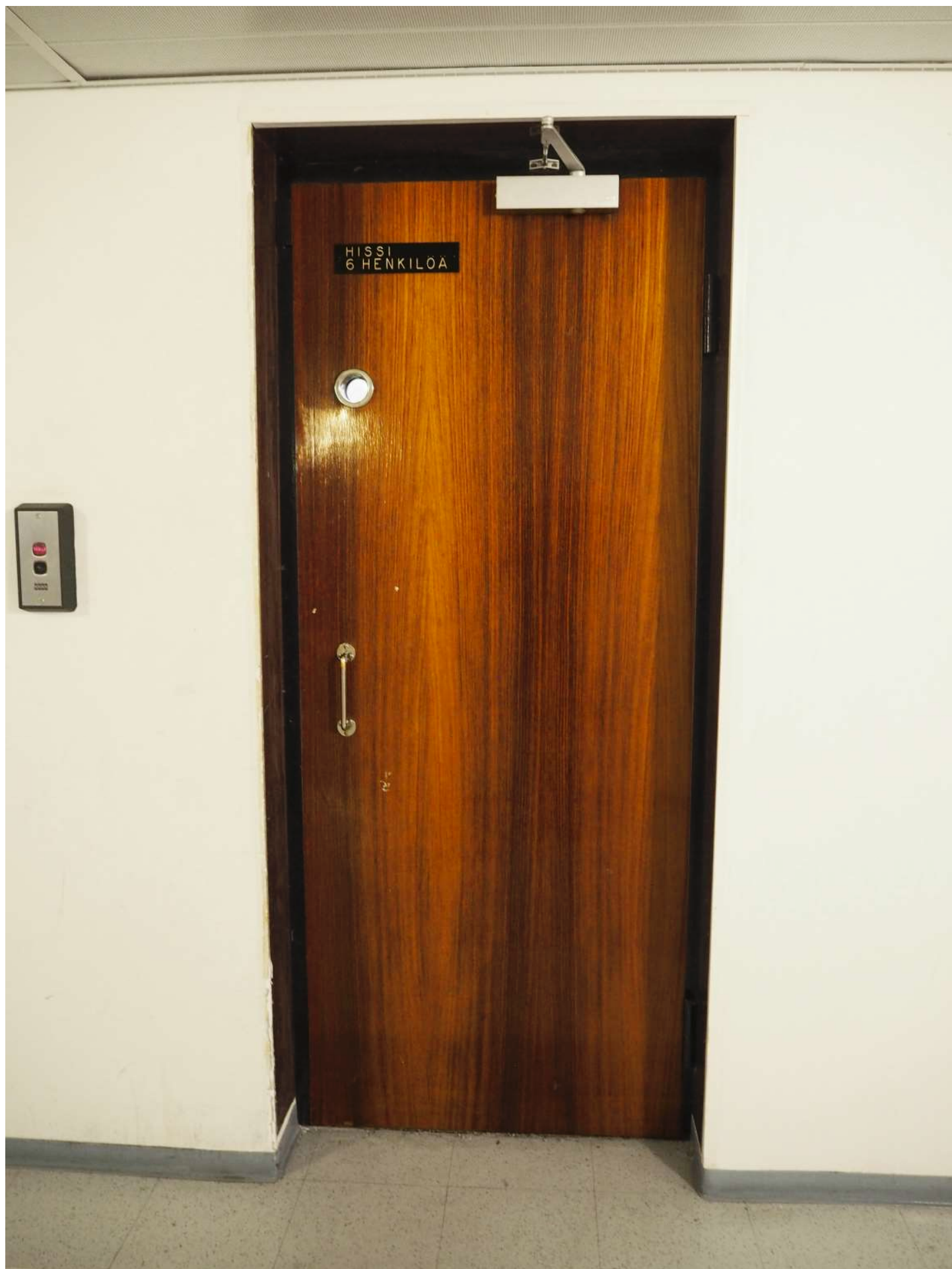
Alkuperäisen hissin ovi on padoukia. Myös ympärivät seinät oli alun perin verhoiltu padouk-puulla. Hissi korjattiin vuonna 1999. 2025. (EH)
