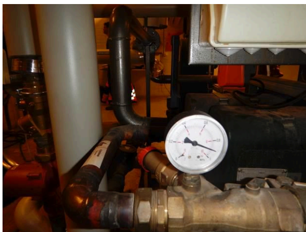
Käyttövesiverkoston painetaso, joka on 900 kPa.
