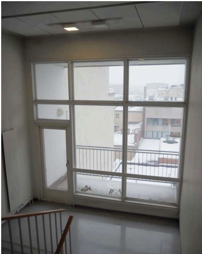
Porraskäytävä A on säilynyt pitkälti muuttumattomana alkuperäiseen verrattuna. 2025. (EH)
