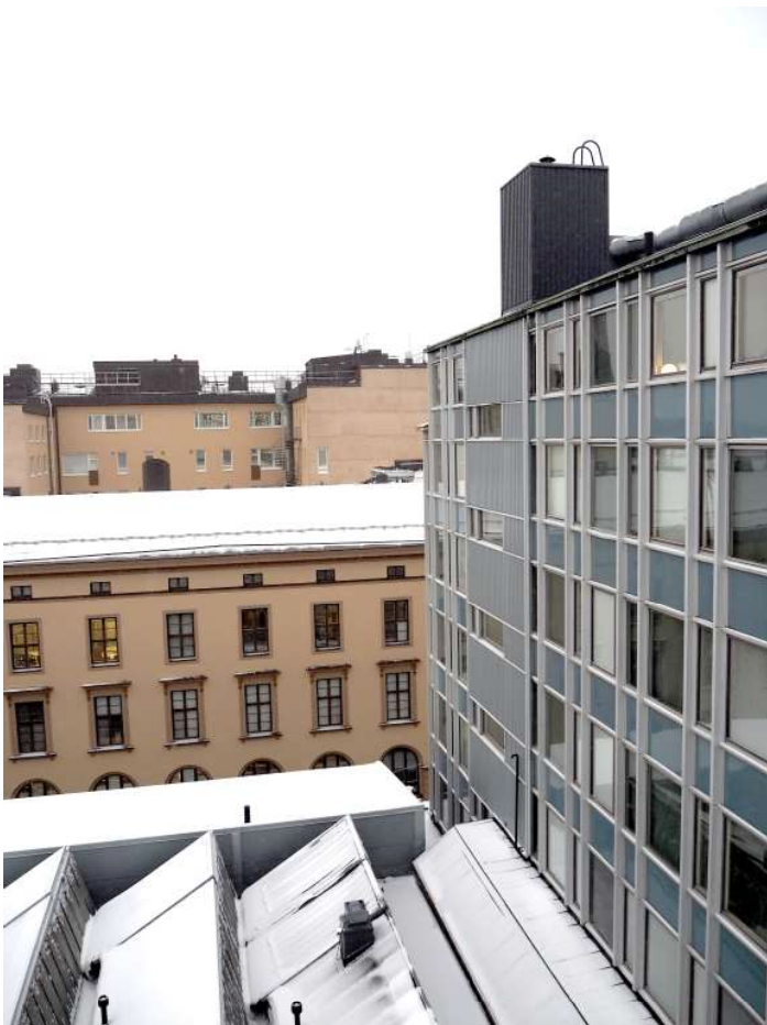
Rakennuksen etelänpuoleinen julkisivu kuvattuna porraskäytävän A tuuletusparvekkeelta. 2025 . (EH)
