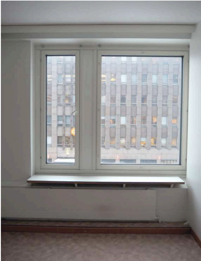
Alkuperäiset keskisaranoidut ikkunat on uusittu todennäköisimmin vuonna 1998. Radiaattori on mahdollisesti alkuperäinen 2025. (EH)
