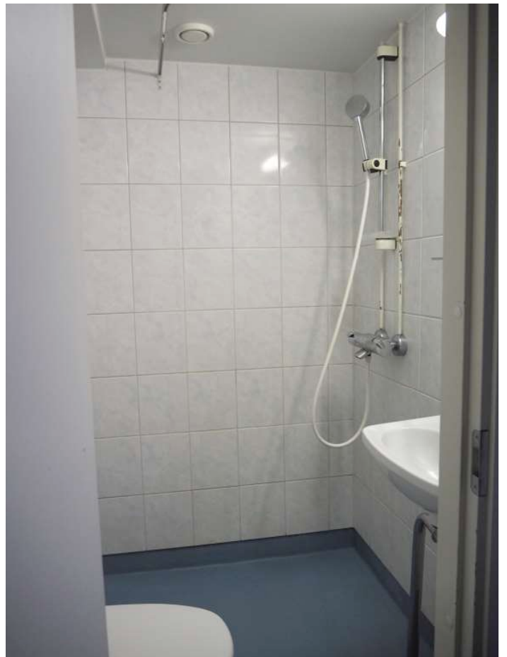
Myös asunnon kylpyhuone on uudistettu viimeksi asuntolamutoksen yhteydessä 1998. 2025. (EH)
