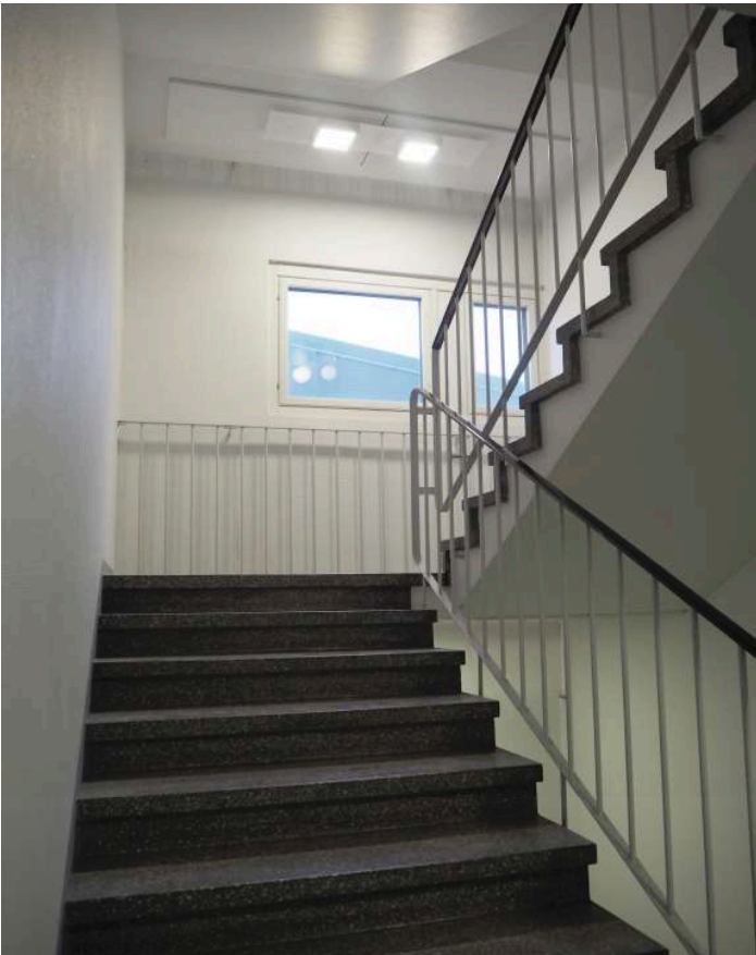
Porraskäytävässä B oli aikoinaan vanhojen julkisivukuvien mukaan samanlainen ikkunalasiseinä kuin porraskäytävässä A. Porraskäytävä uusittiin asuntolan muutoksen yhteydessä. 2025. (EH)
