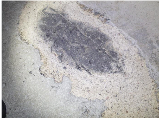
Sementtilastuvillalevyä kellarikerroksen välipohjan alapinnassa.
