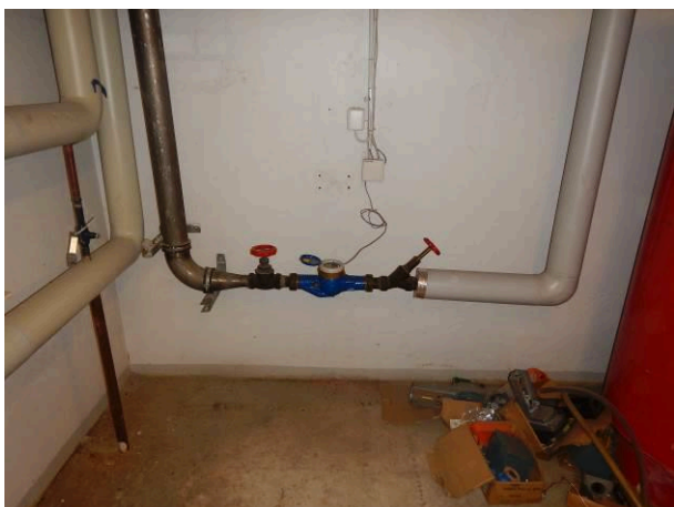
Vesimittari lämmönjakohuoneessa.
