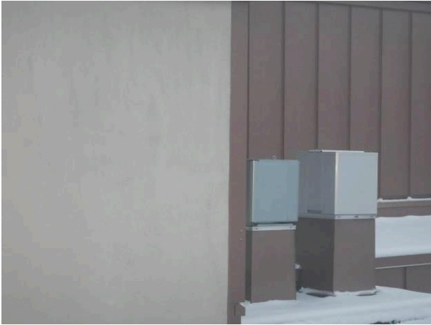
Kiinteistön huippuimureita.
