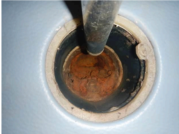
Asuntojen kylpyhuoneiden lattiakaivot ovat osittain vanhoja valurautakaivoja.
