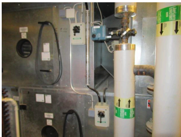
IV-laitteiden sähköasennuksia konehuoneessa
