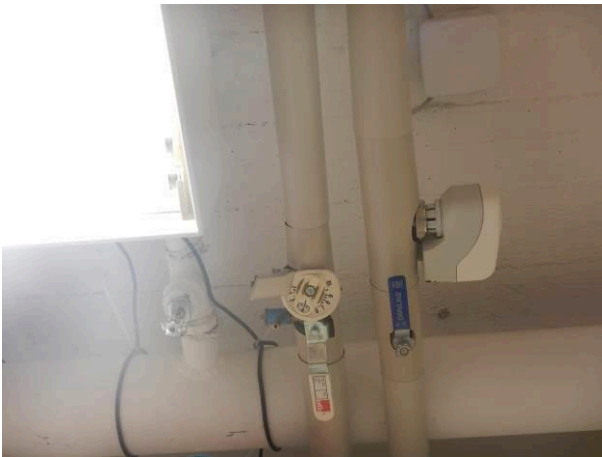
Jäähdytyspalkkeja palveleva lämpösähkötoimilaite ja huonesäädin.
