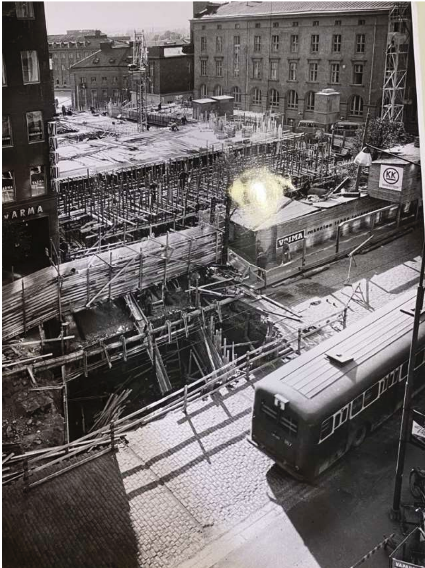
Voiman uuden tavaratalon rakennustyömaa kuvattuna 30.9.1960. Kuvassa näkyy myös Hämeenkadun allittavan yhdystunnelin työmaa. (Staf, E.M. Työvänmuseo Werstas).
