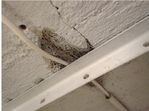
Sementtilastuvillalevyä kellarikerroksen välipohjan alapinnassa.
