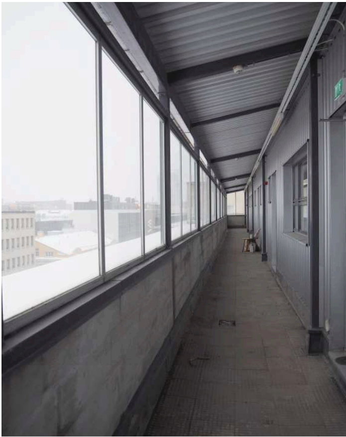
Käynti 8. kerroksen asuntoihin on entiselle kattoterassille 1998 toteutetun luhtikäytävän kautta. 8. kerroksen tilajako on pohjapiirrosten perusteella vanhan kaupunginhotellin tilakokonaisuuksista parhaiten säilynyt alkuperäiseen verraten. 2025. (EH)
