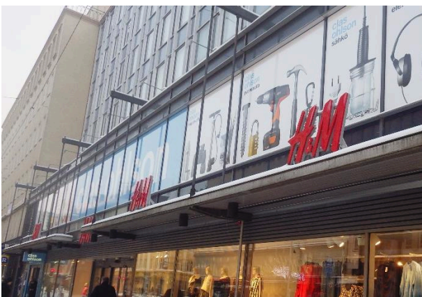
Liiketilojen sisäänkäyntikatoksia ja niiden kannakointi.
