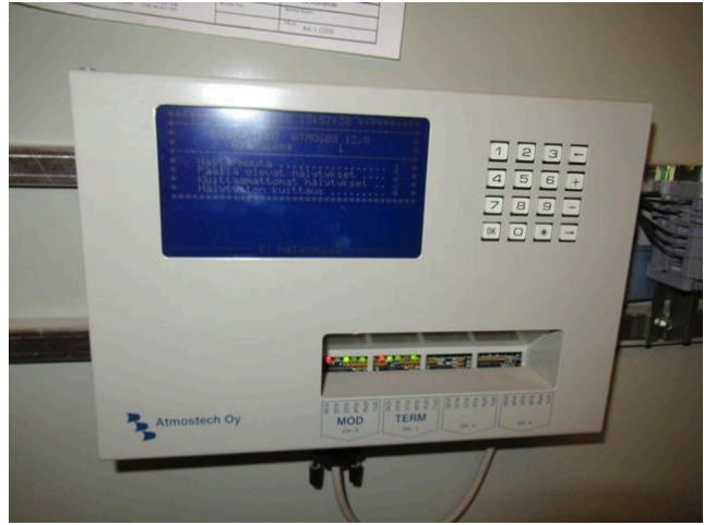
Valvonta-alakeskuksen 1 käyttöpääte
