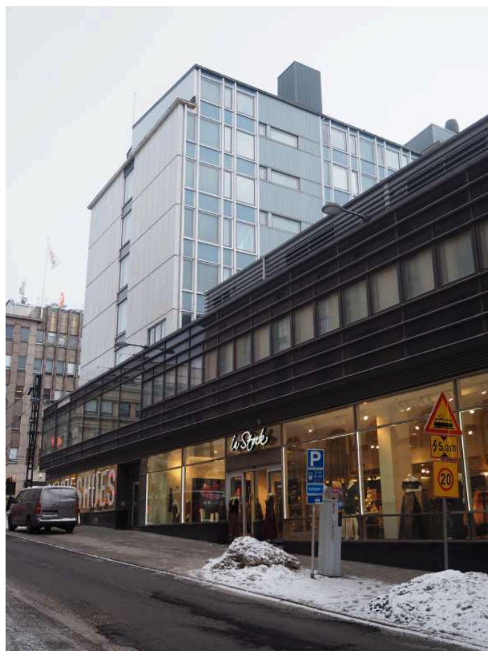
Liiketilöiden julkisivut vastaavat vuoden 1997 suunnitelmia. Kuvas- sa näkyy myös samana vuonna toteutettu kolmannen kerroksen vesikatolla sijaitsevan IV-konehuoneen laajennus. Korkean osan profiiloitu vaalensininen peltijulkisivu toteutettiin vuoden 1998 peruskorjauksen yhteydessä. (EH)
