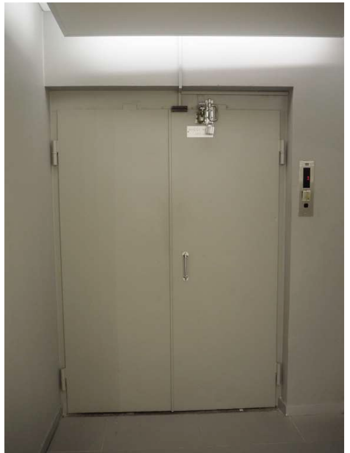
Alkuperäinen tavaratalon tavarahissi on edelleen paikoillaan. 2025. (EH)
