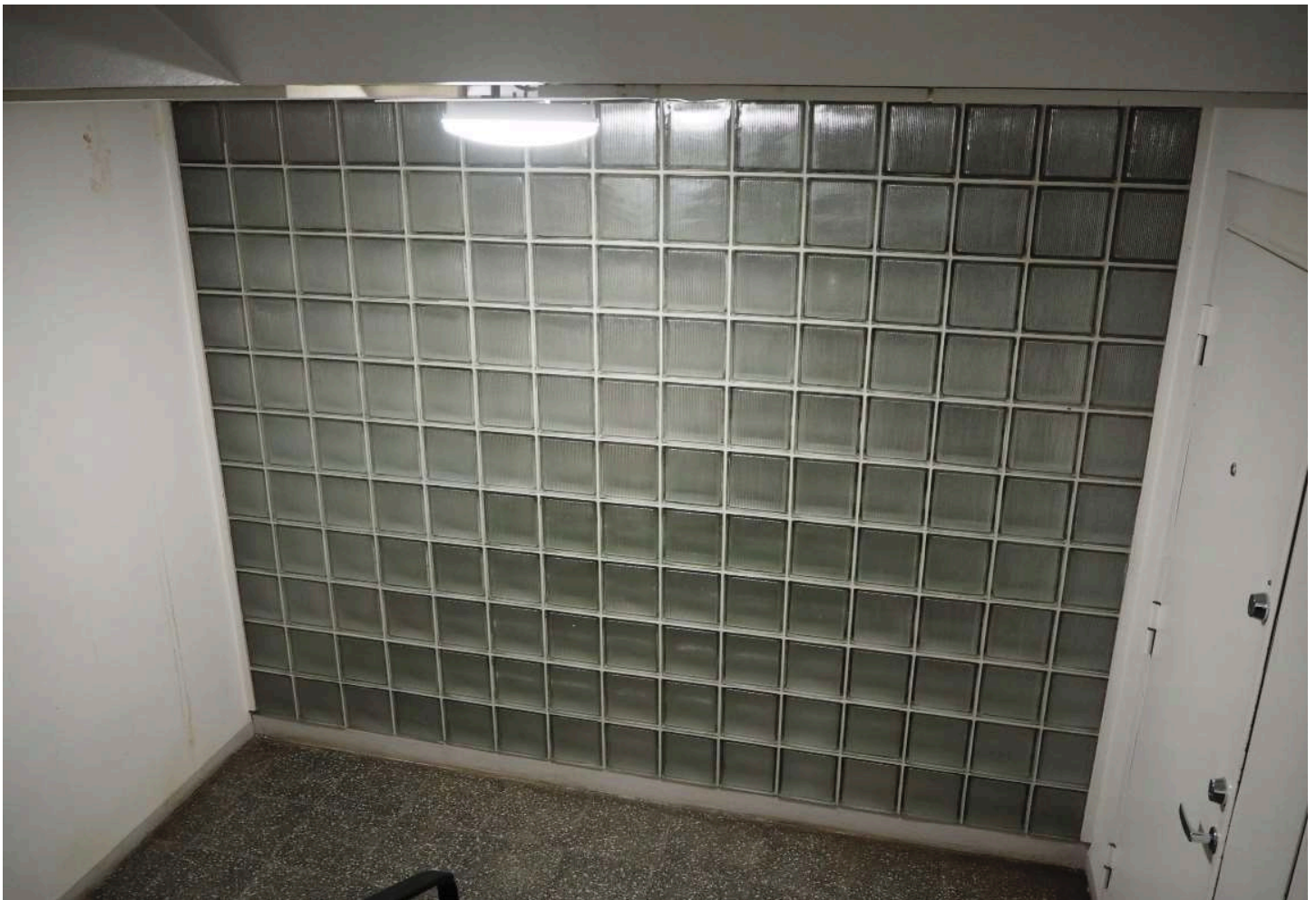
Porraskäytävässä on säilynyt alkuperäistä lasitiiliseinää. 2025. (EH)
