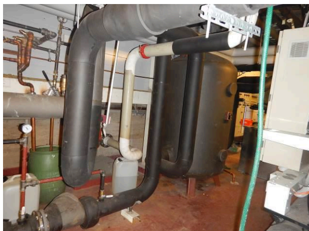
Kiinteistön jäähdytysvesiverkoston asennuksia.
