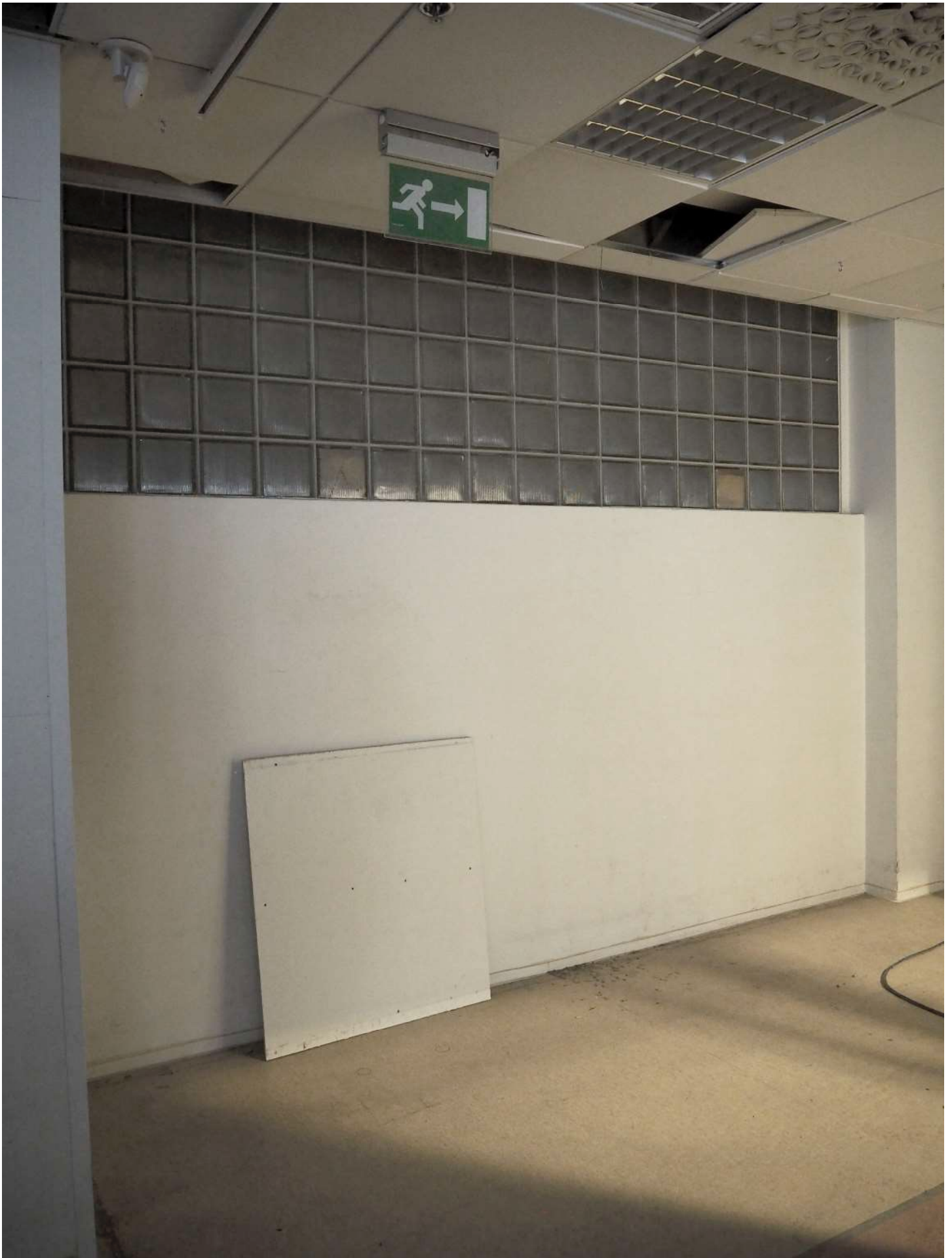
Alkuperäinen lasitiiliseinä toisen kerroksen liiketiloissa. 2025. (EH)
