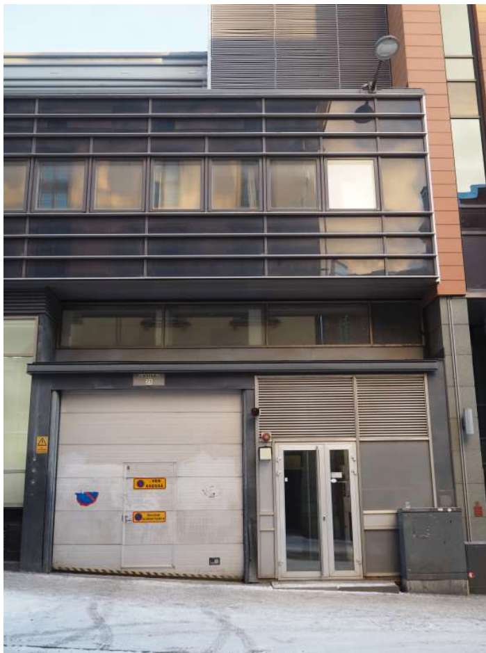
Rakennuksen päätyjulkisivulla on alkuperäinen Arabian klinkkerilaatta. Päädyssä kolmannessa kerroksessa oikealla sijaitseva ikkuna ei ole alkuperäinen, eikä sen lisäämisajankohta ole tiedossa. 2025. (EH)
