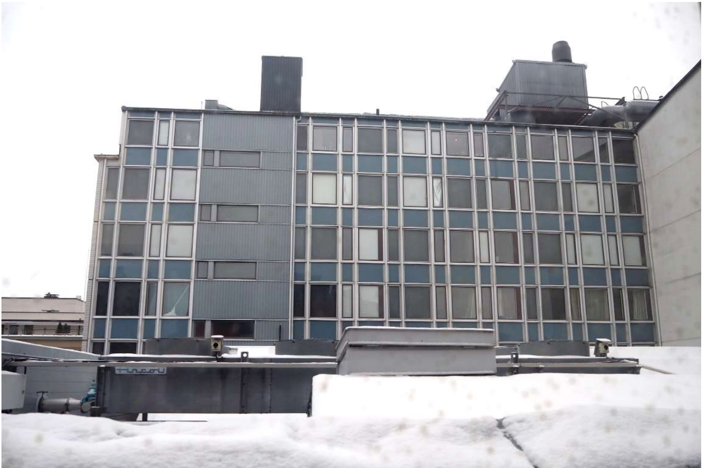
Rakennuksen etelänpuoleinen julkisivu kuvattuna porraskäytävän C ylimmältä tasolta. 2025 . (EH)
