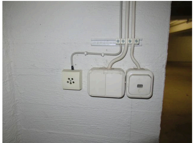
VSS-tilan pistorasia-asennuksia
