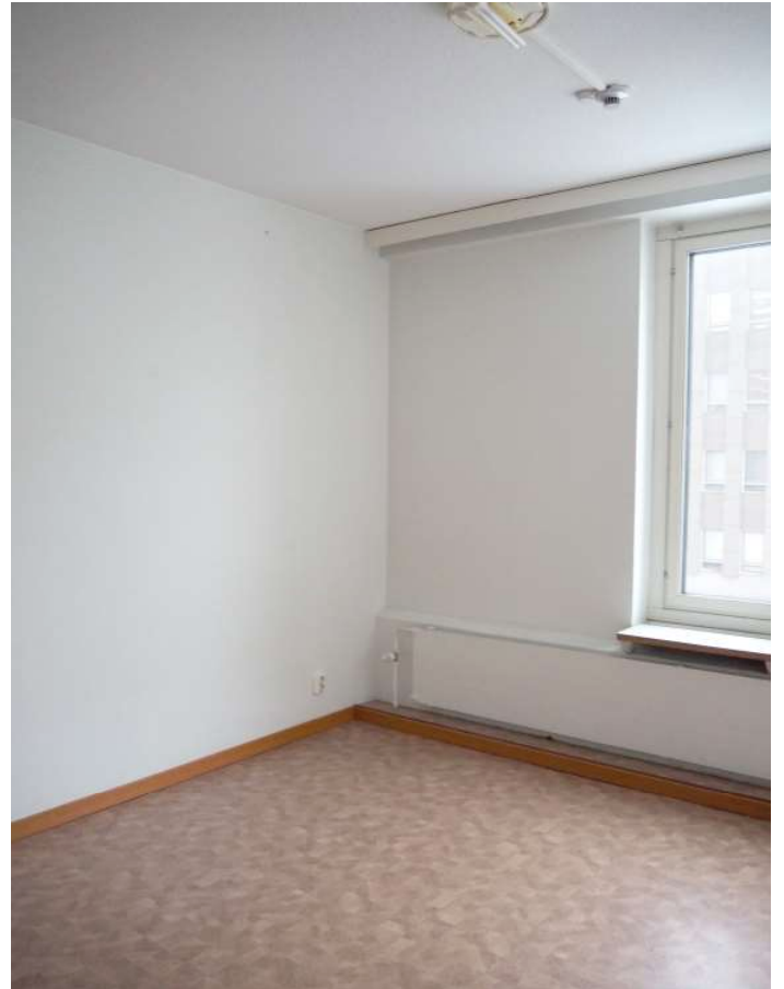
Alun perin koko ulkoseinä oli ikkunaa. Osa ikkunaseinästä ummistettiin asuntolamutoksen aikaan. 2025. (EH)
