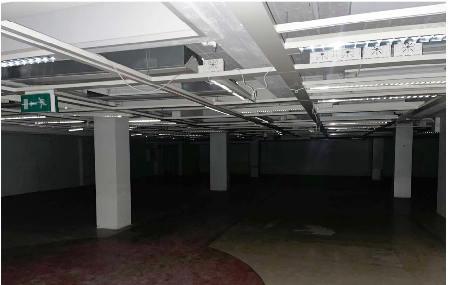
Toisen kerroksen liiketilan takaosa. Tilan katossa on viisi suorakulmion muotoista kattoikkunaa, mutta niistä tuleva luonnonvalo on peitetty ja ikkunat häviävät alakatossa tekniikan sekaan. Paikallavaletut palkit ovat näkyvissä katossa. 2025. (EH)
