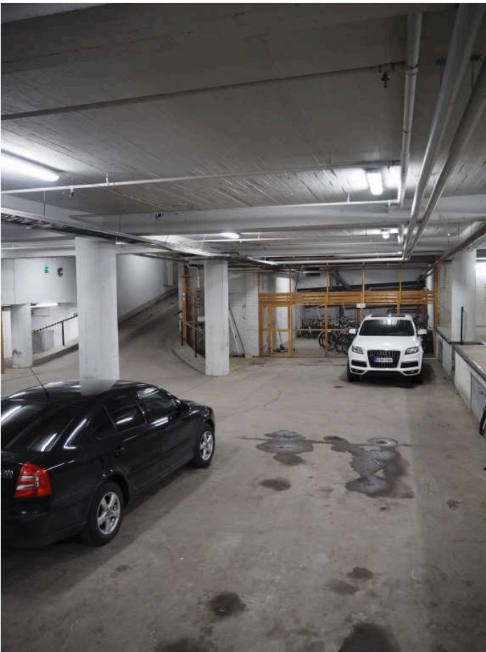
Autohalli ja lastaustila ylemmässä kellarikerroksessa. Paikallavaletut pinnat ovat näkyvissä 2025. (EH)
