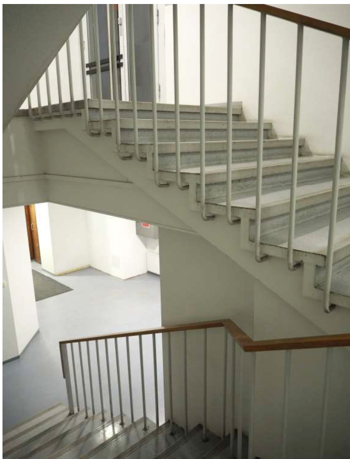
Alkuperäinen porras ja kaide. Porras on pinnoitettu uudelleen myöhempien muutosten yhteydessä. 2025. (EH)
